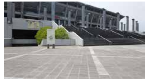
写真④ 大階段の上下が広場
