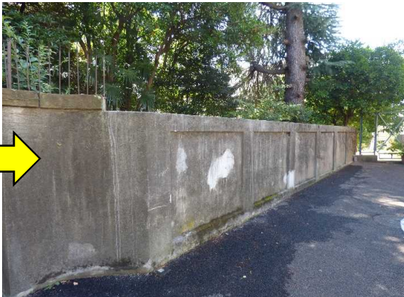
(改善後) 附属高等学校ブロック撤去 C
